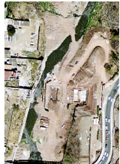
Vac_u: Construction site
