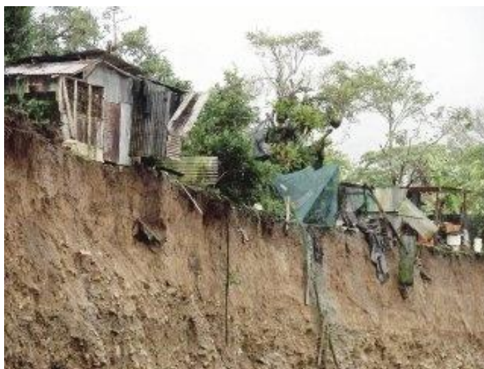
Figura 1-3. Deslizamiento en el costado del cauce del río Grande de Orosí
