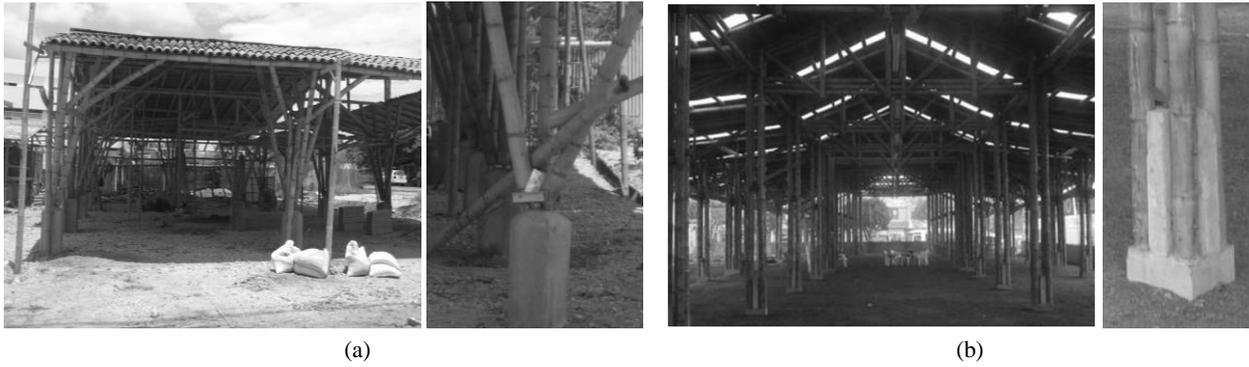
Figura 1: (a) Estructura sin una conexión rígida a su cimentación. (b) Estructuras con conexión columna - cimentación aparentemente rígida
