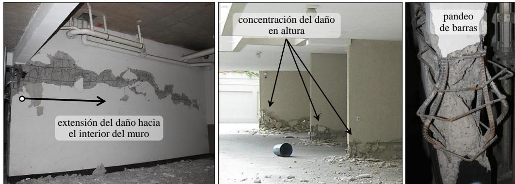
Figura 1: Daño en los extremos de muros estructurales durante el terremoto de Chile (2010).
