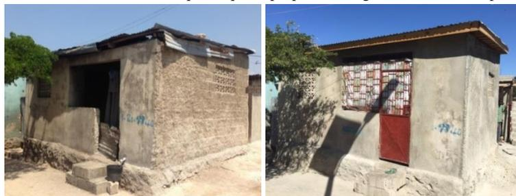
Figura 3: Casa en Puerto Príncipe antes (izquierda) y después (derecha) de un reforzamiento sísmico
